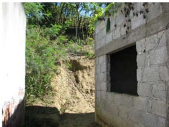
Vista de la parte posterior de una casa de la manzana 10. Fotografía de Rubén Galicia.
