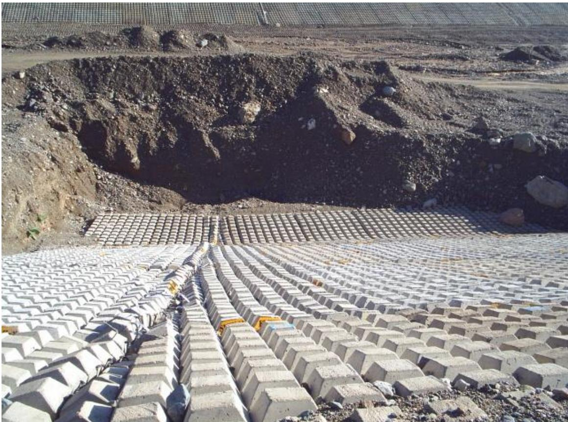
**Fig. 2.8** Un extremo del tapete se entierra en el fondo del río y el resto de la estructura cubre el margen hasta el bordo; los tapetes van unidos entre sí por medio de flejes metálicos.
